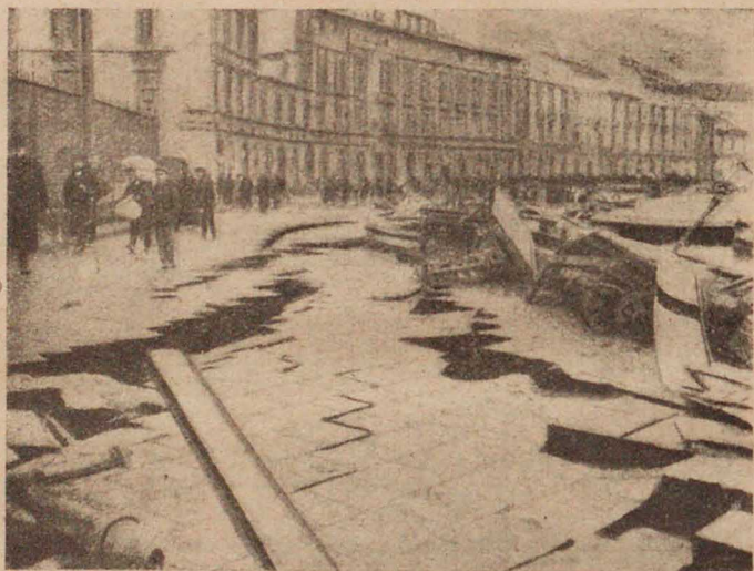
Рис. 33. Мессина. Трещины разорванной мостовой.
