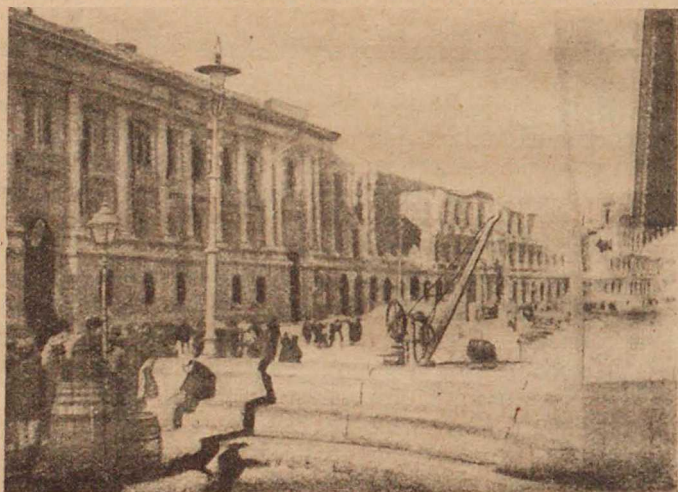
Рис. 34. Мессина. Каменная лестница, давшая трещину.
