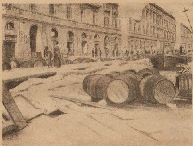
Рис. 37. Развороченная мостовая в Мессине, указывающая на волнообразное движение почвы.
